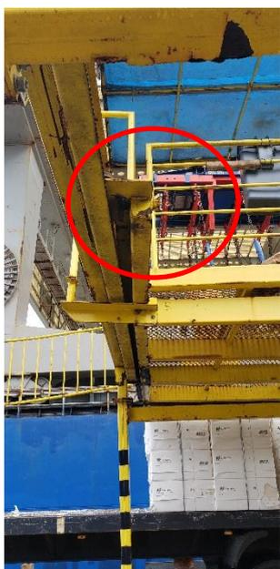
01 – Trilho do basculante da plataforma n 5 avariado, impedido o perfeito funcionamento – Necessário reparo imediato.
