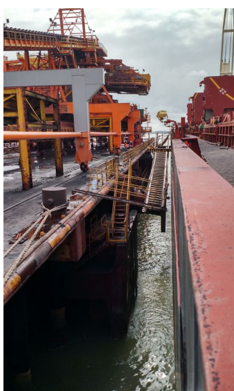
Figura 6: Rampa estreita, ausência de apoio rolante, falta de rigidez do conjunto, obstáculos na escada e ausência de rede de proteção
